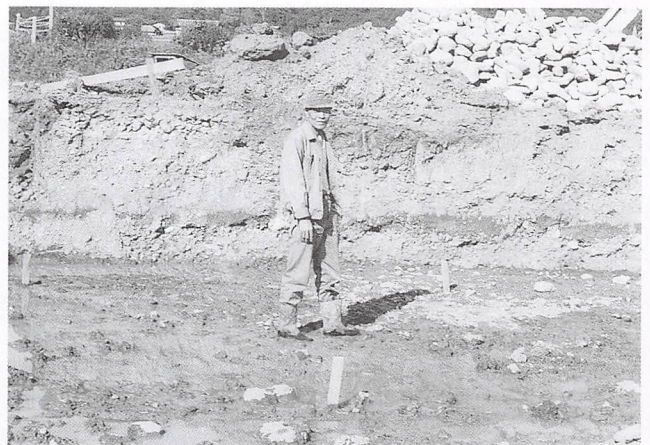
第5図 小鹿野小学校新校舎建設現場
