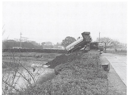
② ダンプ進入用のスロープを造る
