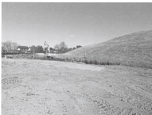
③ バックホウ、ブルドーザーによる敷均し
