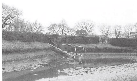
1 埼玉用水路と接続するヒューム管
