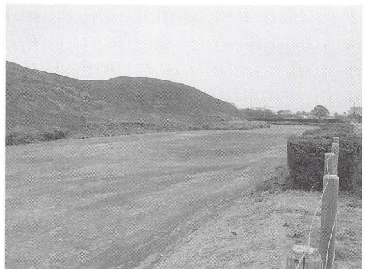
④ 完成 (平成25年度施工区)
