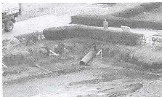
2 県道側溝と接続するヒューム管
