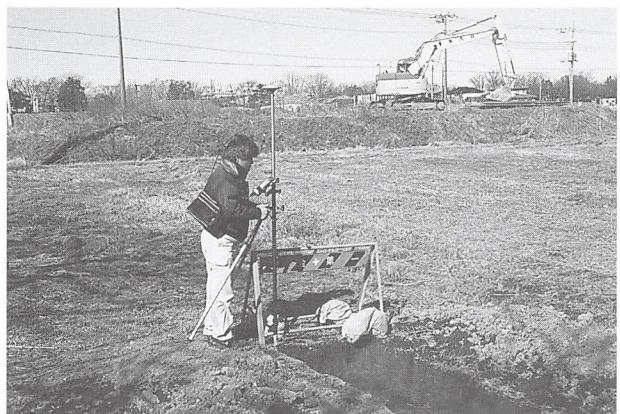
写真11 GPS測量の状況
