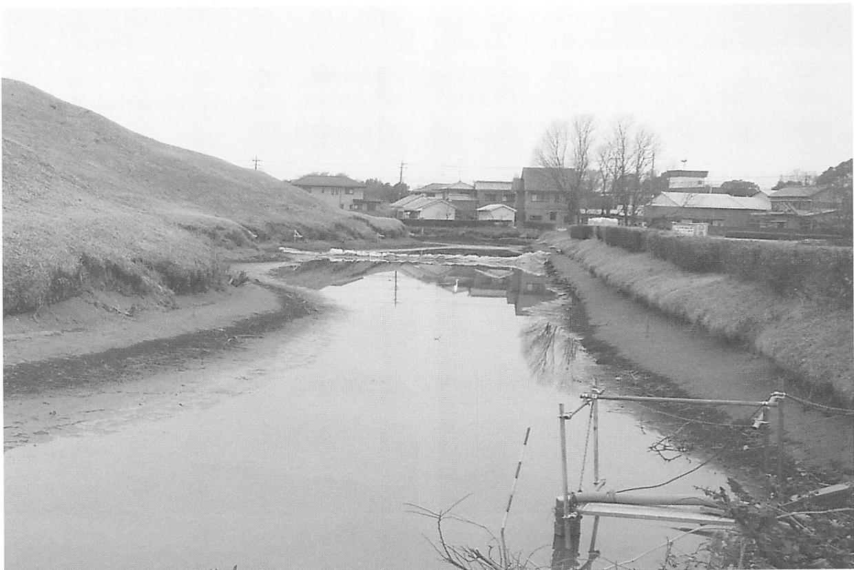
② 平成 25 年 2 月 (墳丘裾は約 1.5m 後退している。中堤も下部が完全に流出している)
