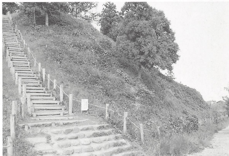
同 上 (西から・工事实施前)
