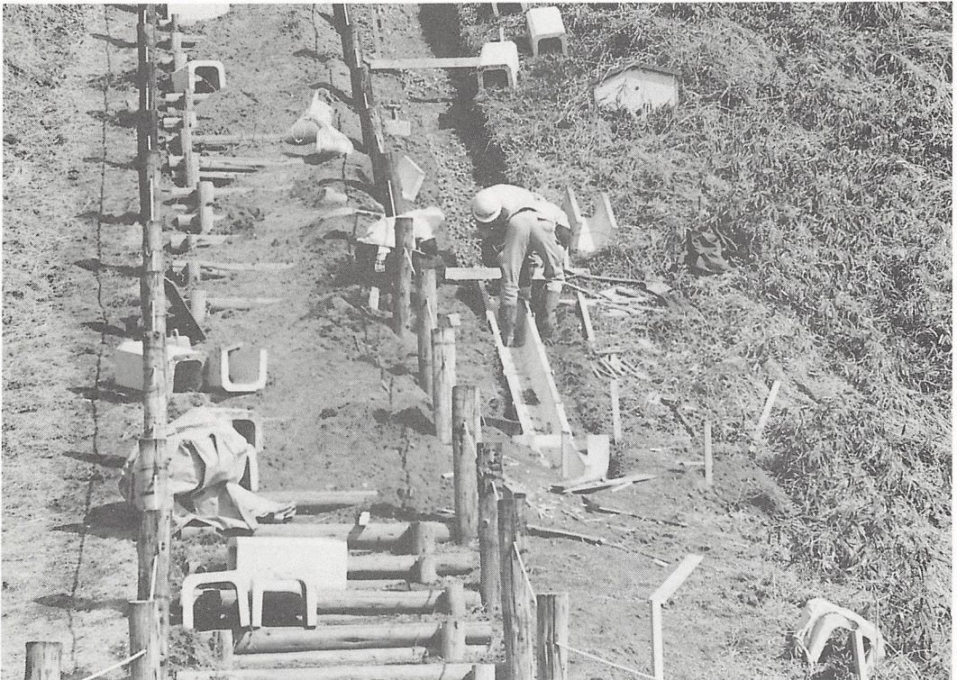
U字側溝敷設
