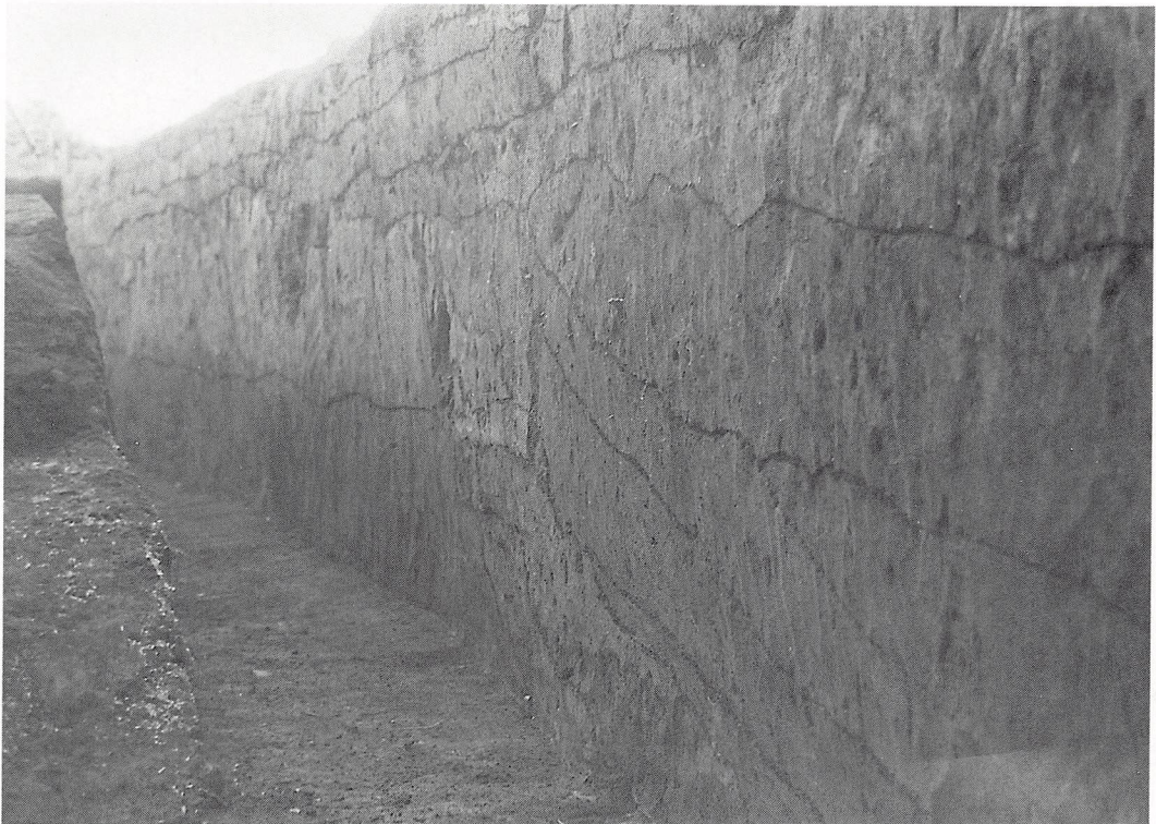
6 内堀の立上がり状態
