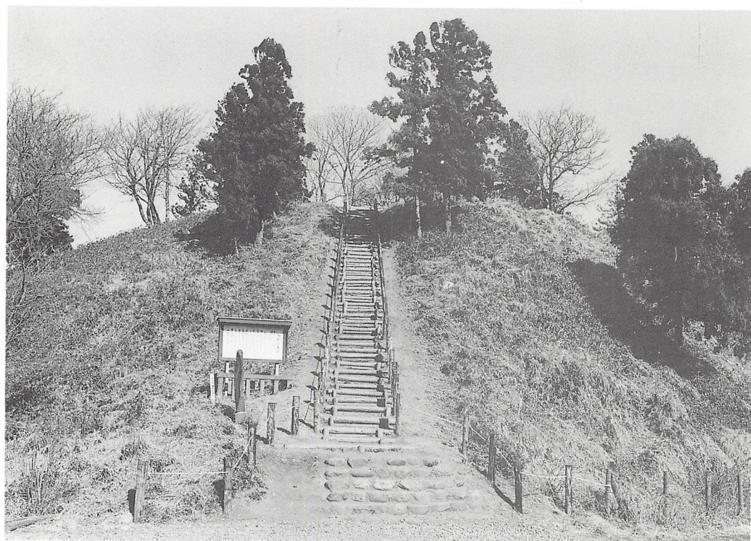
同 上（工事実施前）
