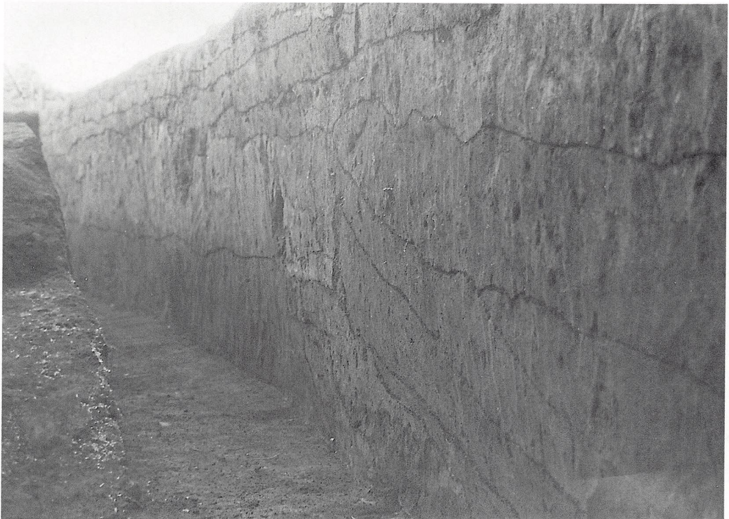
6 内堀の立上がり状態
