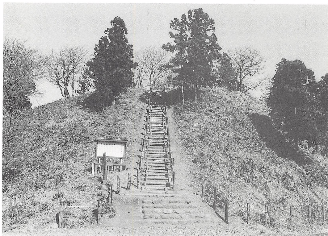
同 上（工事実施前）
