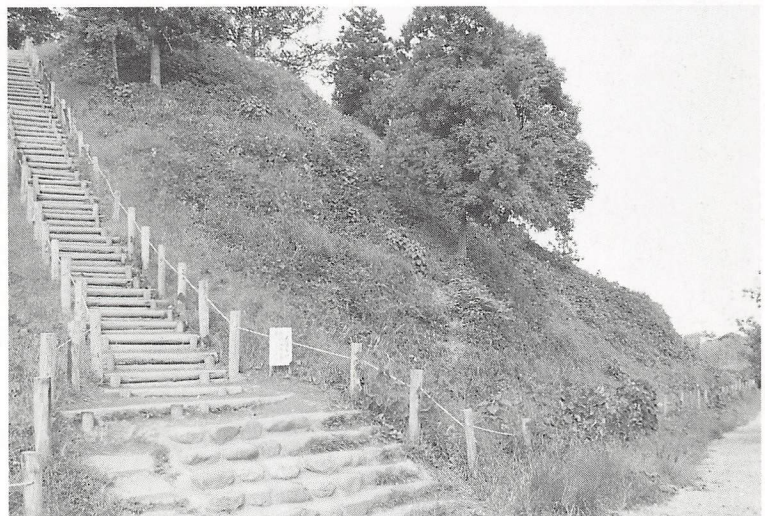
同 上 (西から・工事实施前)
