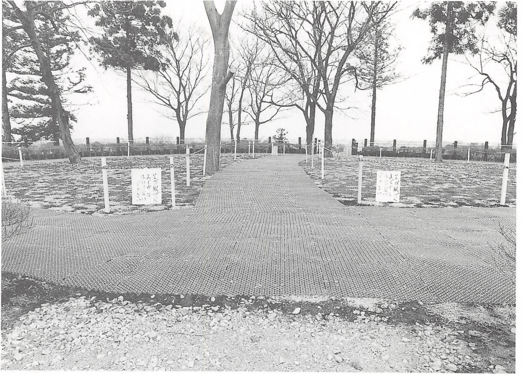
墳頂部（工事实施後）
