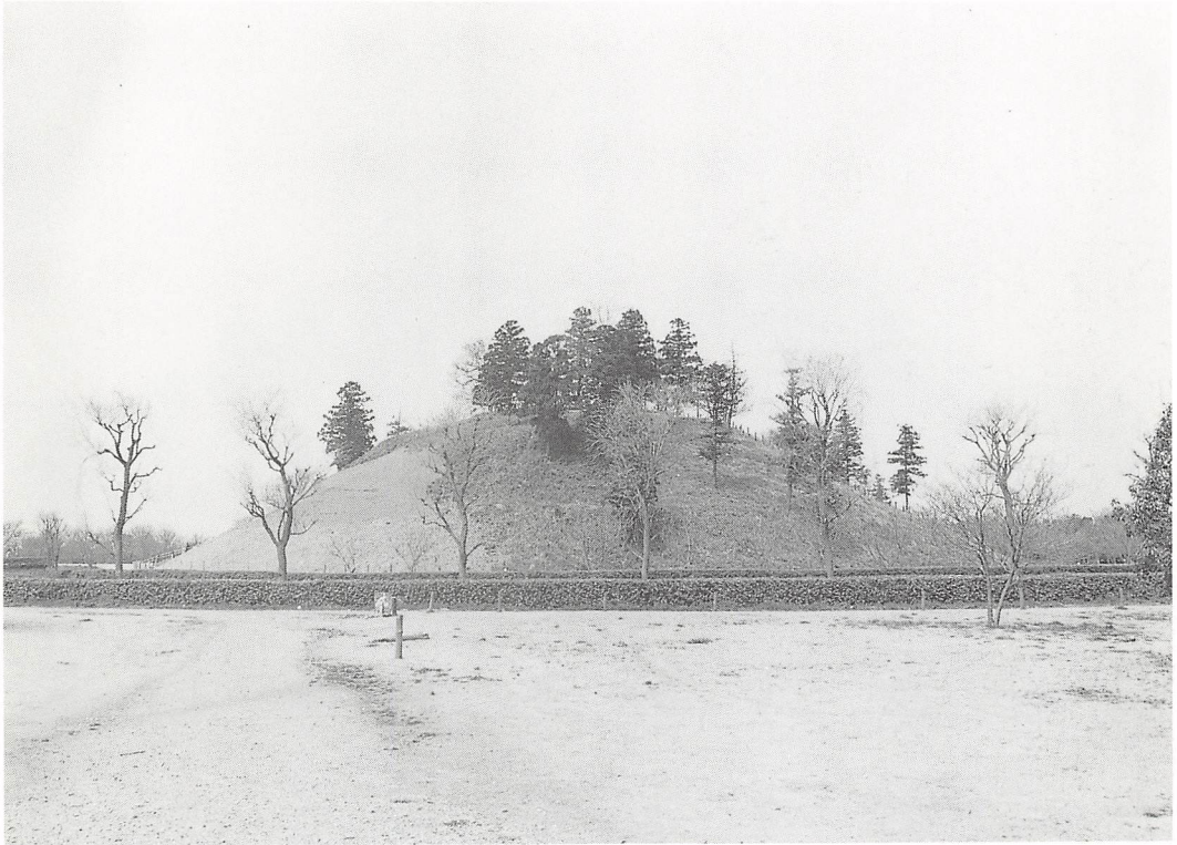
丸墓山古墳全景（東から・工事実施後）
