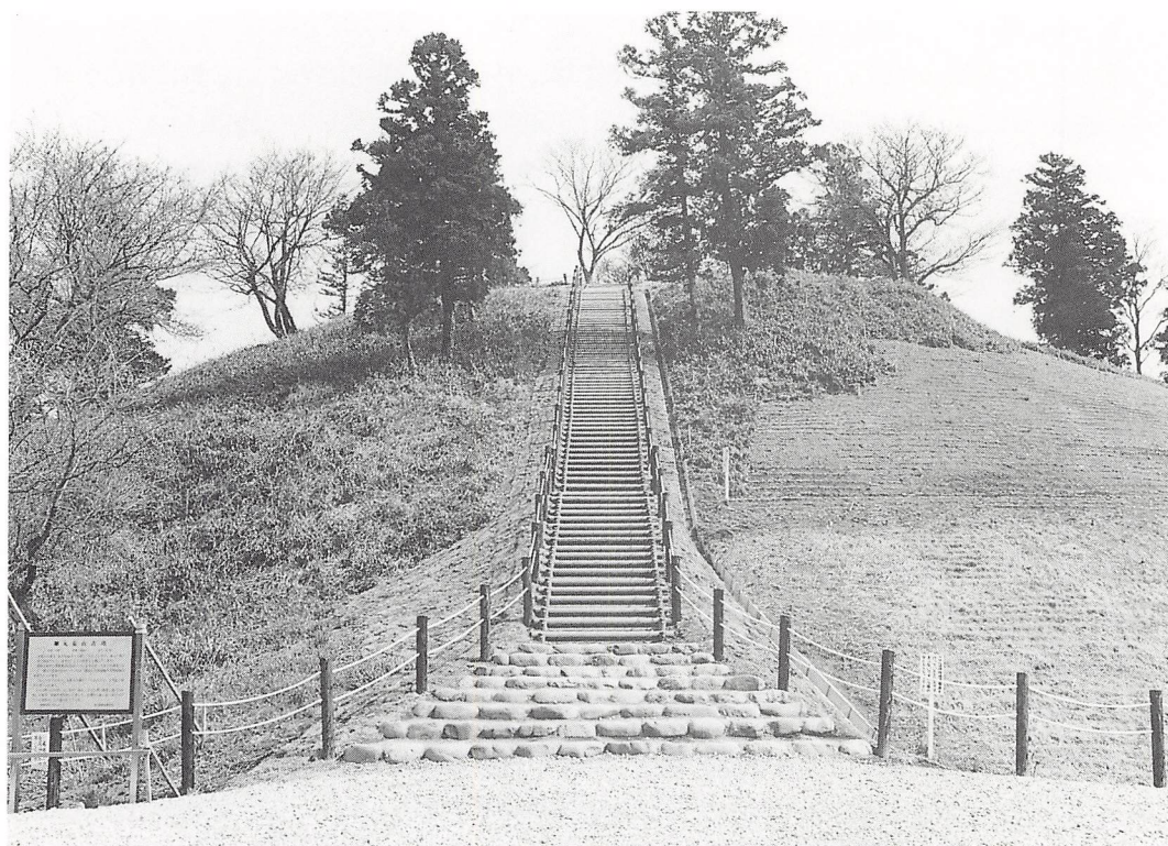
丸墓山古墳近景（工事実施後）
