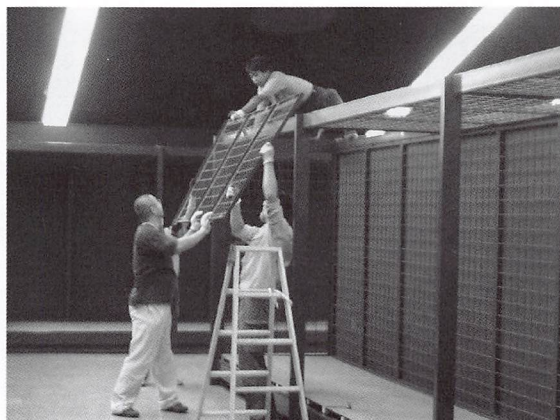
民俗展示室内の什器解体作業
