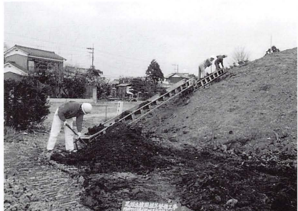
写真4 墳丘西側の盛土工
