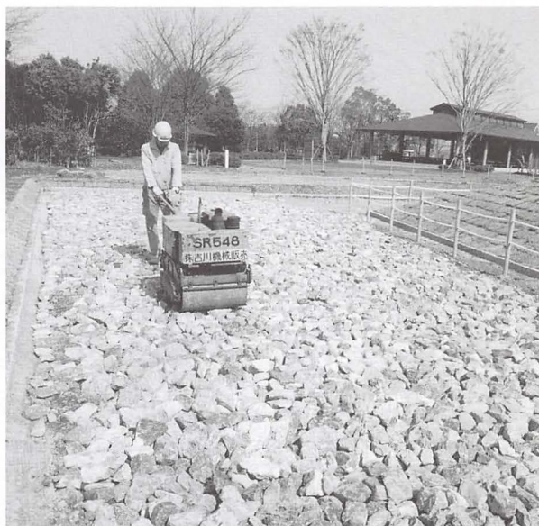
写真23 周堀床面栗石の転圧
