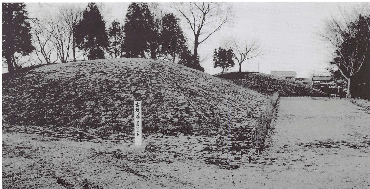
写真3 整備工事完成状況
