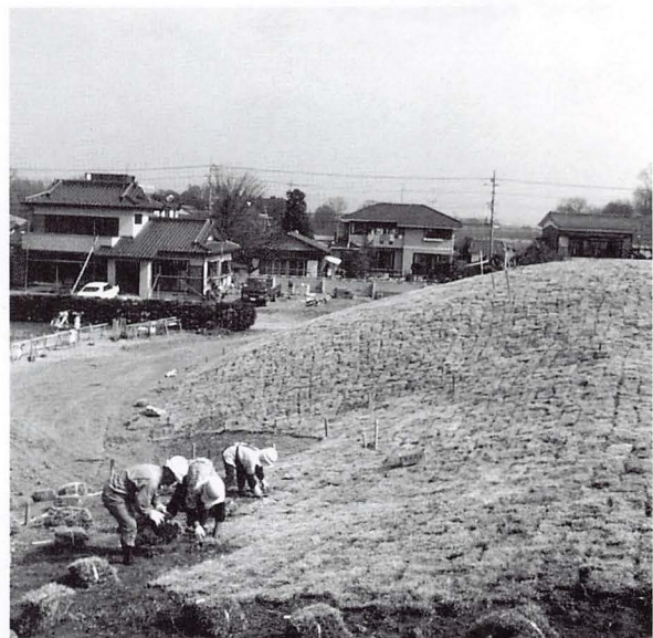
写真6 墳丘西側の芝張工事
