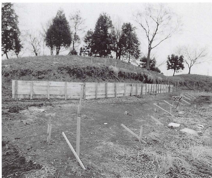
写真2 杉丸太と松板による土留工
