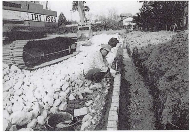
写真 15 東側外堀の周堀立体表示工事
