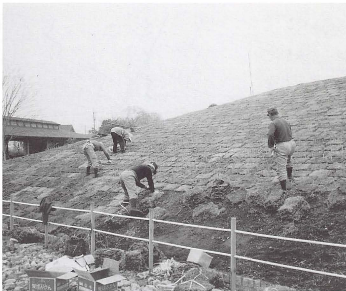
写真21 前方部正面張芝工事
