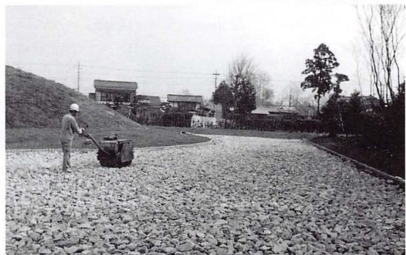
写真5 墳丘東側内堀の立体表示工事
