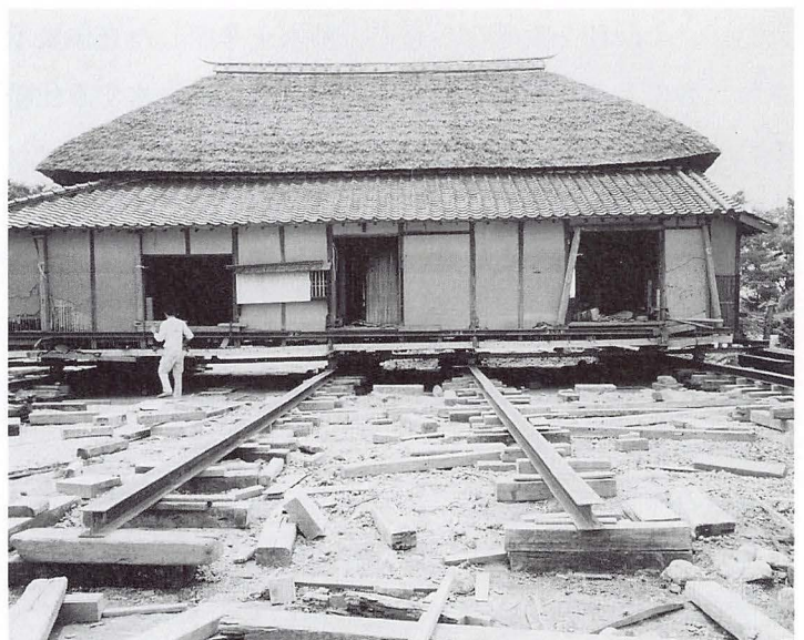
写真19 旧山崎家曳家工事（レール上を移動）
