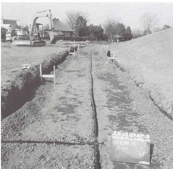
写真22 前方部正面部分の暗渠排水溝工事
