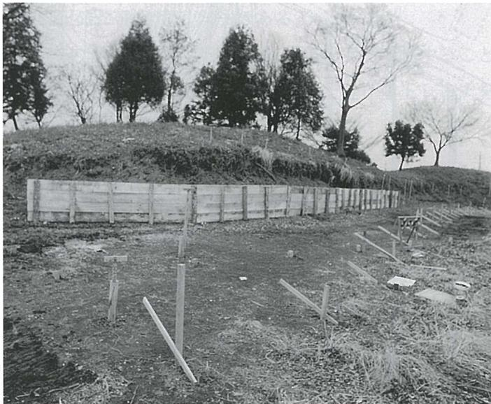
写真2 杉丸太と松板による土留工
