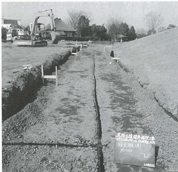
写真22 前方部正面部分の暗渠排水溝工事
