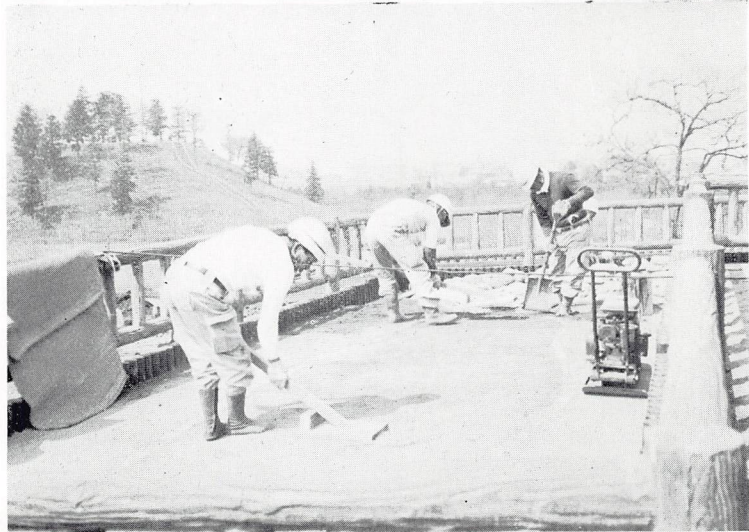
主体部防護柵内路床改良 (同上)
