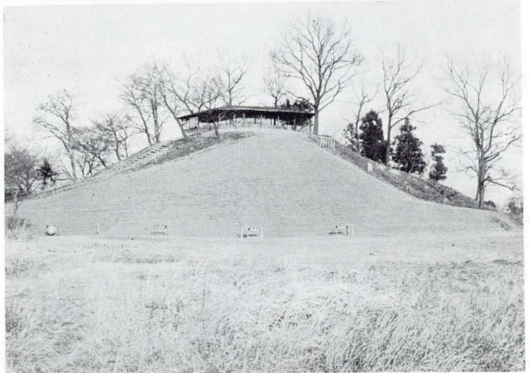
完成後の崩壊崖面保護法面 (同上)
