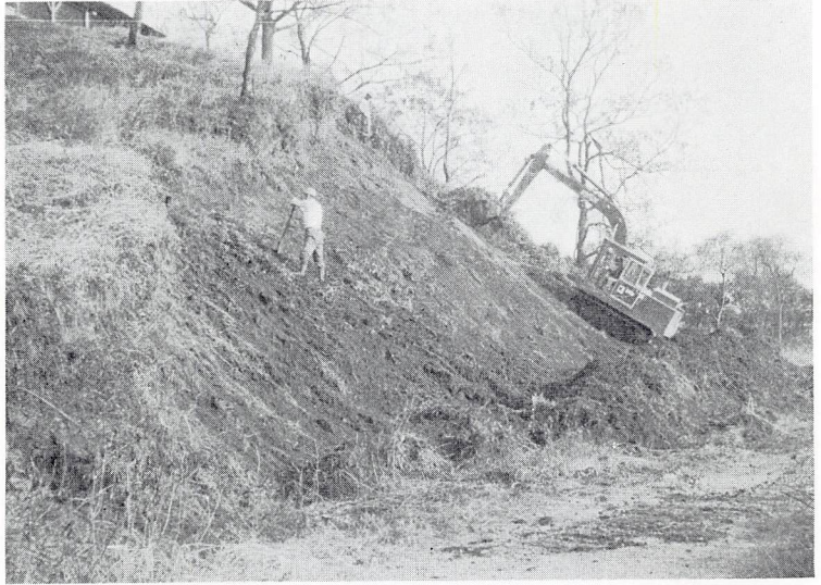
後円部南側崩壊土の除去 (昭和57年度)
