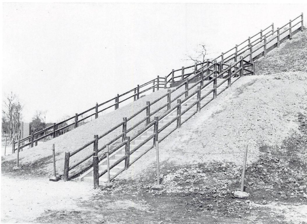
新設鉄製階段（南から）
