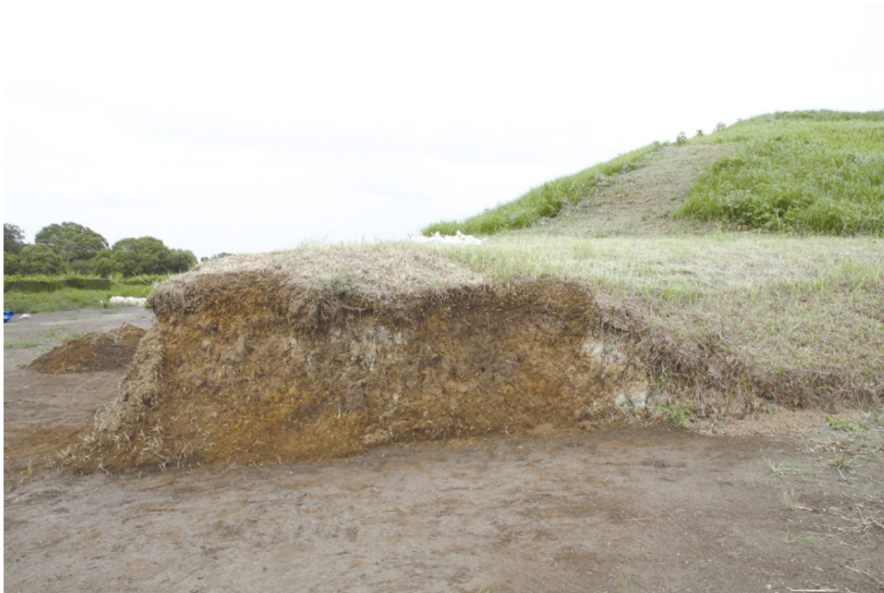
Ⅱ区 25-1T 発掘前 墳丘裾部崩落状況
