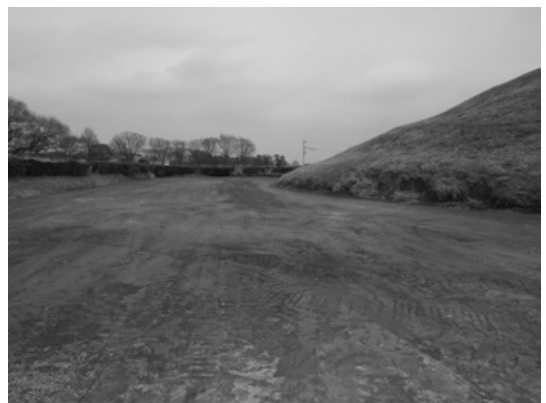
図113 埋立後の様子（平成27年3月撮影）
