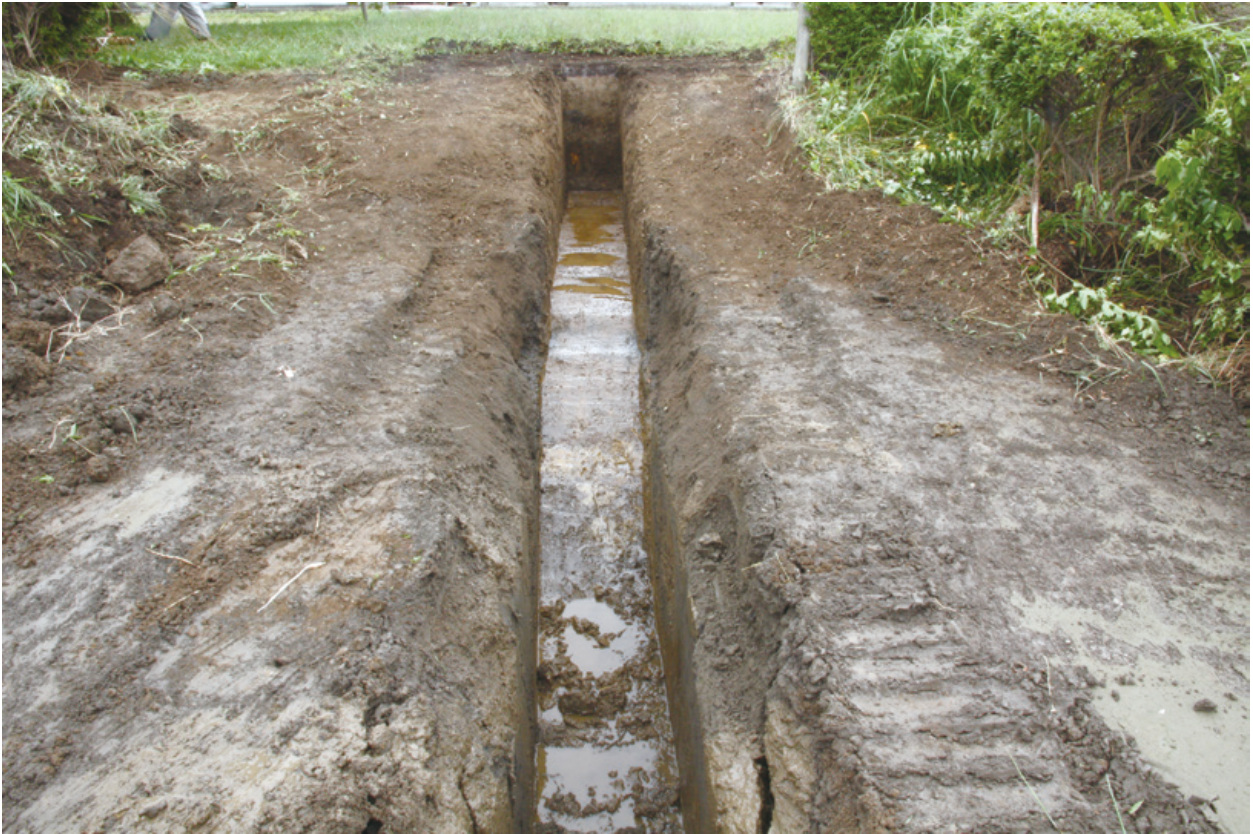
Ⅲ区 25-5T 全景（北から）
