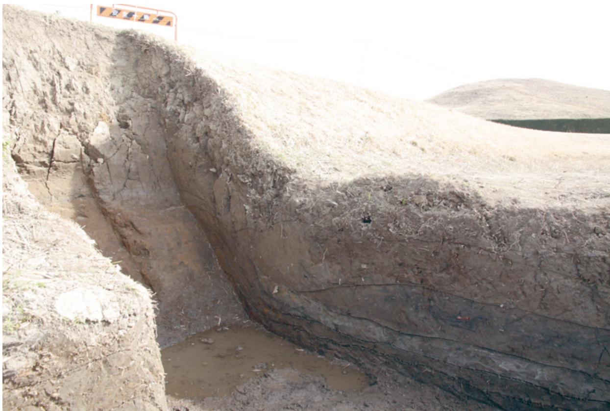
IV区 30-2T 中堤造出し付近
