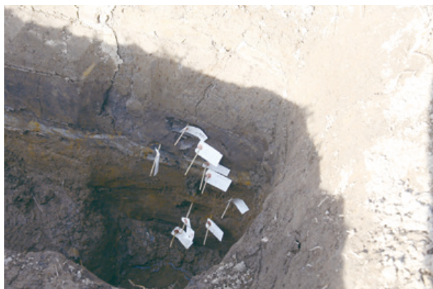
IV区 28-8T 土壌サンプル採取状況
