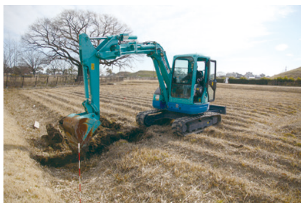
Ⅱ区 28-1T 埋め戻し重機風景
