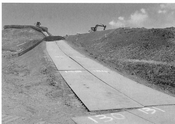
13年度 盛土工事仮設搬入路
