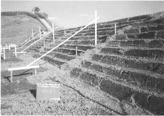
12年度 盛土段切工事
