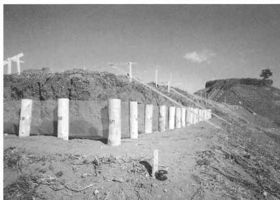
14年度 しがら柵設置工事
