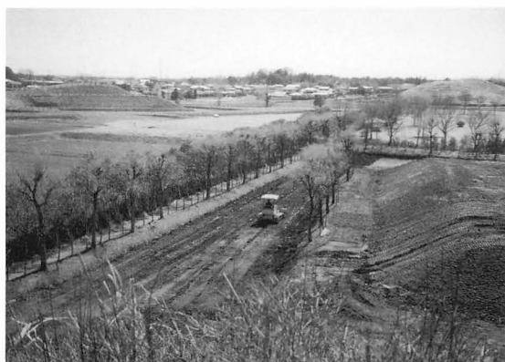
10 年度 周堀埋立工事 (東側)
