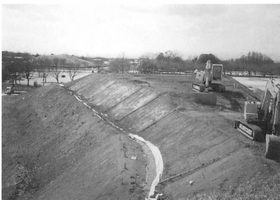
14年度 法面整形工事終了状況
