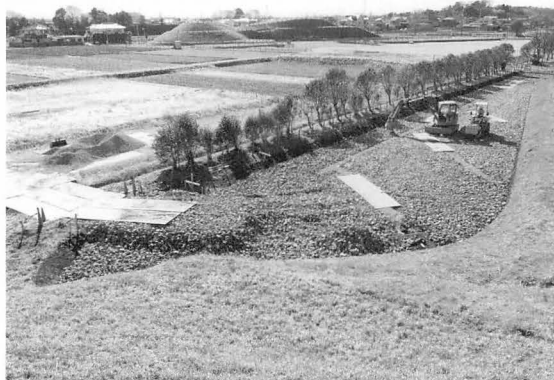
17年度 周堀修景碎石舗装工事（東側）
