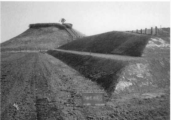
12年度 法面整形工事完了（西側）
