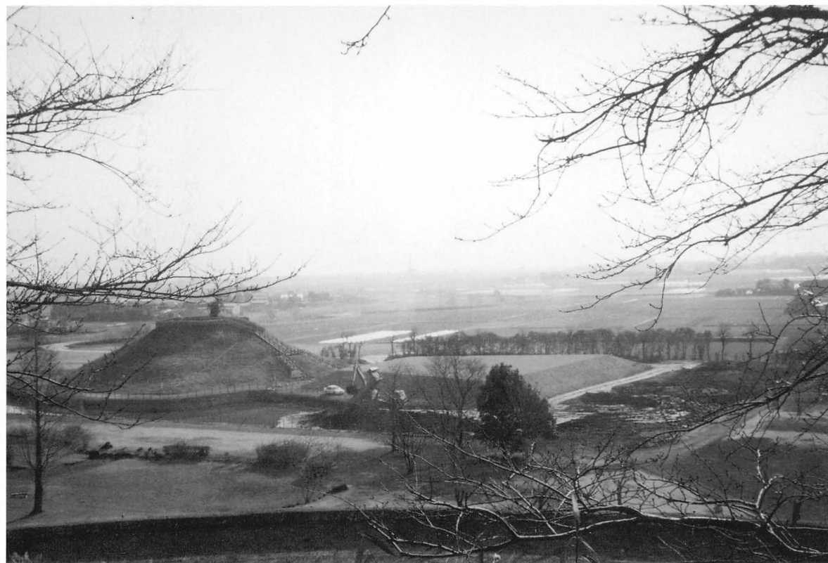
11 年度 全景と周堀埋立工事 (西・南側)
