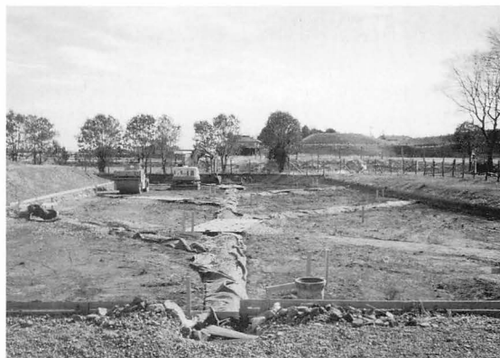
17年度 周堀排水路有孔管設置工事
