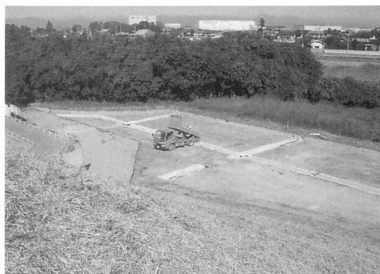
18年度 周堀排水路有孔管設置状況
