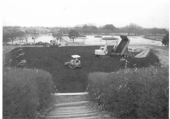
13年度 盛土工事
