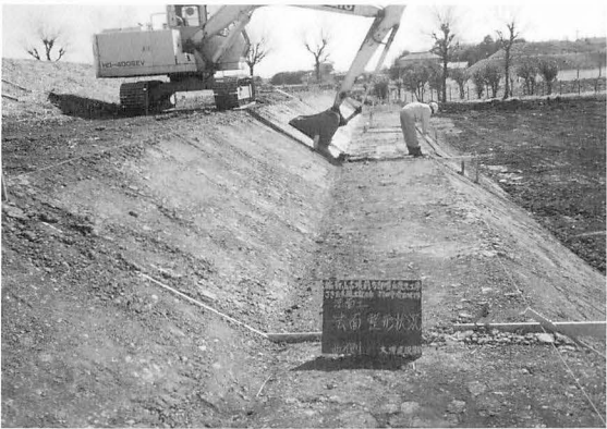
12年度 法面整形工事
