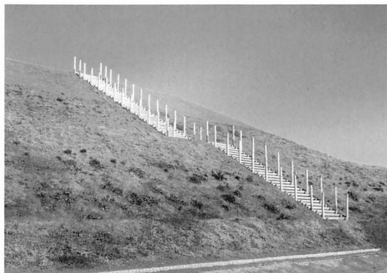
15年度 前方部丸太階段工事
