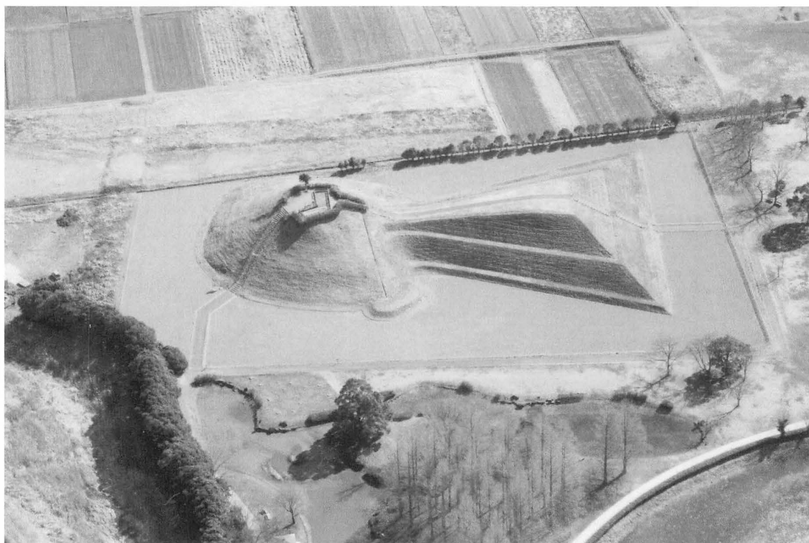
18年度工事完了状況空中写真
