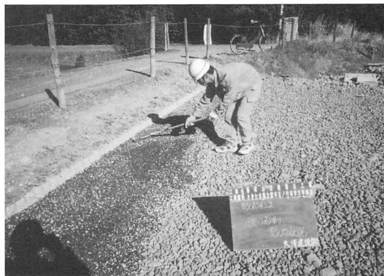
16年度 周堀修景敷砂利工事
