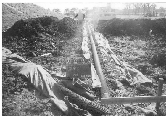
16年度 周堀排水路有孔管設置工事
