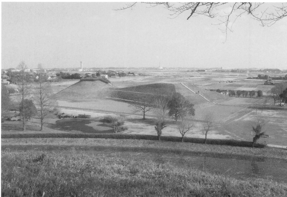
18年度工事完了状況遠景
