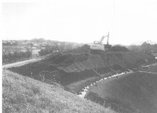
14年度 盛土工事近景
