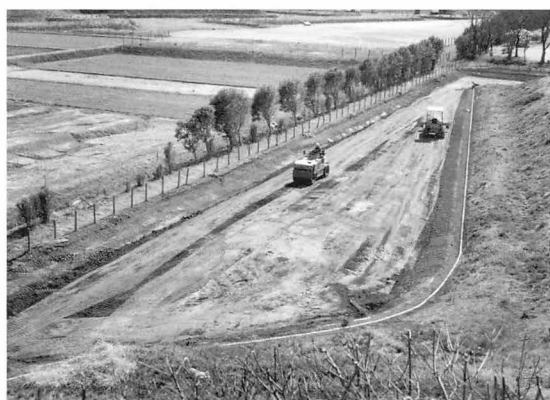
15年度 周堀埋立土漉き取り工事（東側）
