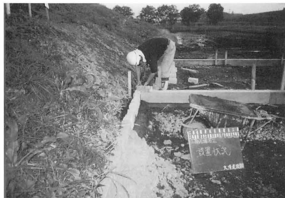
16年度 墳丘裾小舗石縁石工事
