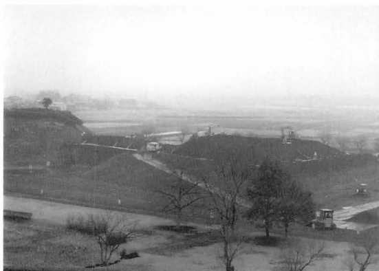
14年度 盛土工事遠景
