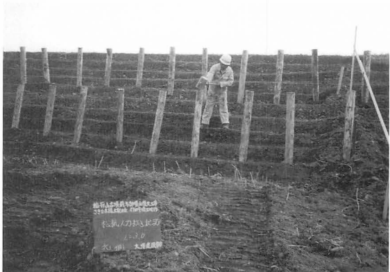
12年度 しがら柵工事丸太打作業
