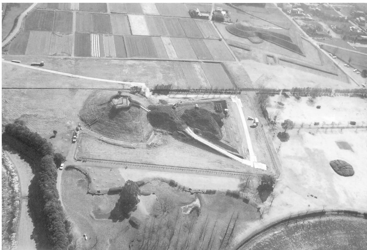
14年度 盛土工事空中写真
