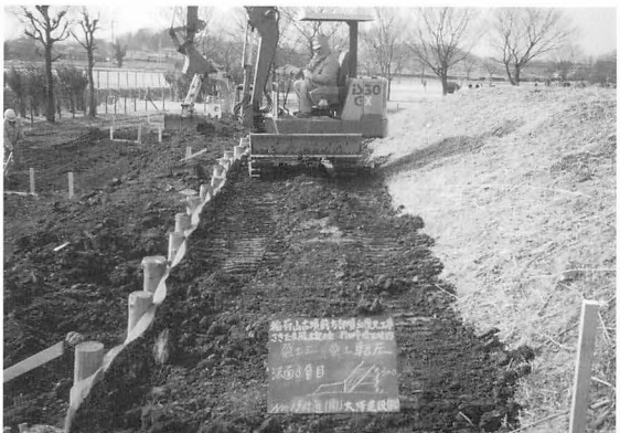
12年度 盛土工事填圧作業
