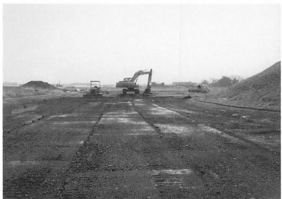
17年度 周堀埋立土漉き取り工事（北側）
