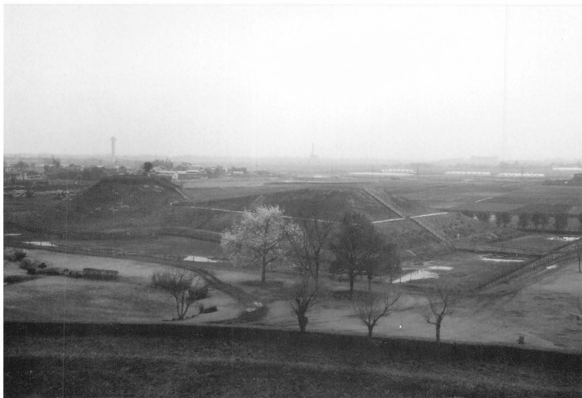
15年度工事完了状況遠景
