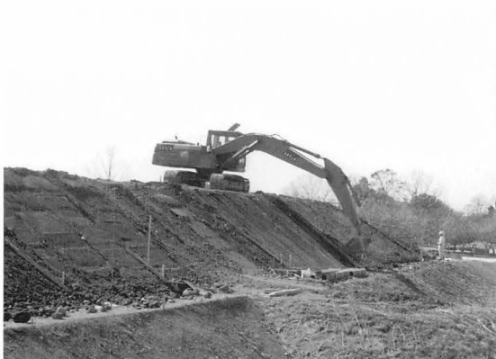
14年度 法面整形工事
