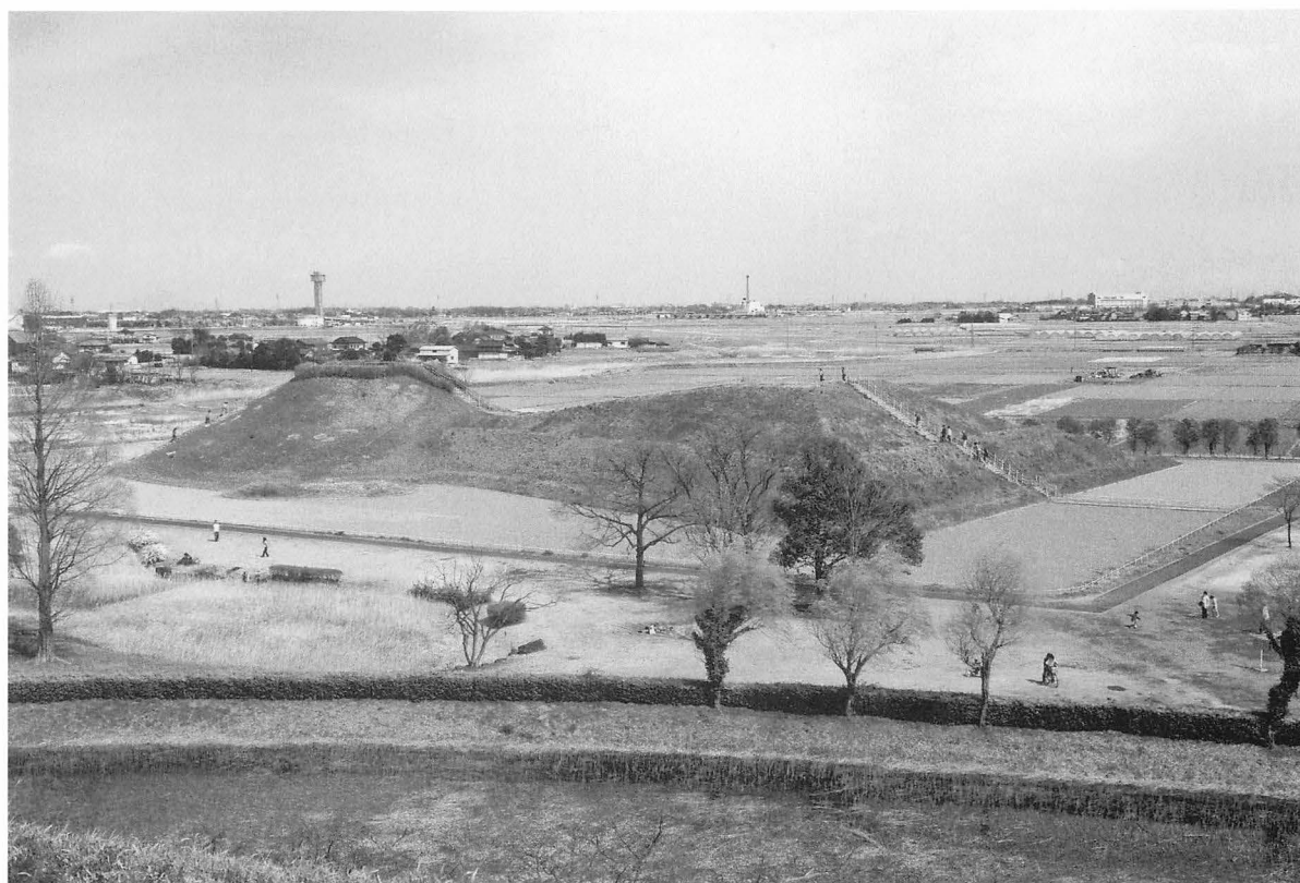
17年度工事完了状況遠景
