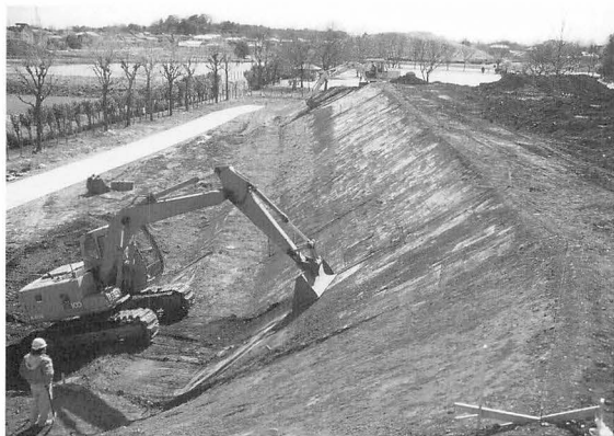
13年度 法面整形工事（東側）
