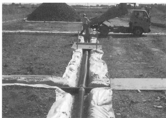
18年度 周堀排水路有孔管設置工事
