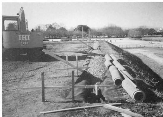
14年度 テラス部暗渠側溝設置工事
