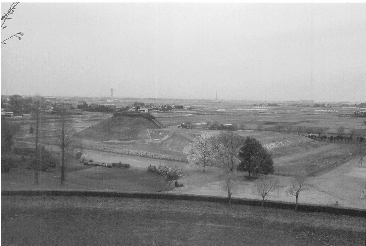
13年度工事完了状況遠景
