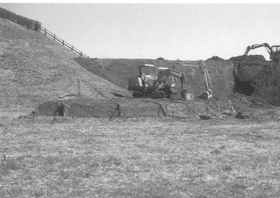
13年度 くびれ部盛土工事
