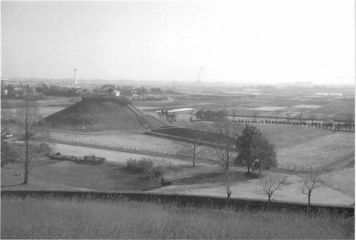
12年度工事完了状況遠景
