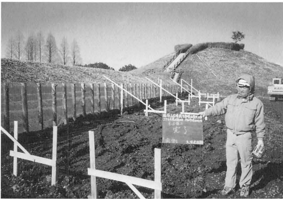
12年度 しがら柵工事ネット張り作業
