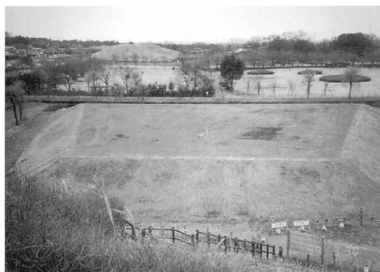
10 年度 前方部盛土工事完了状況
