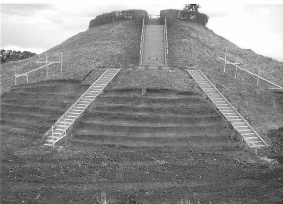
13年度 後円部南側段切工事
