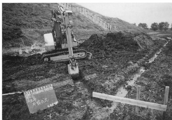
16年度 周堀排水路有孔管設置工事
