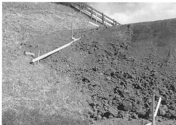
13年度 くびれ部盛土擦付け状況（西側）
