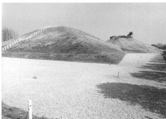
17年度 周堀修景敷砂利工事完了状況（東・南側）
