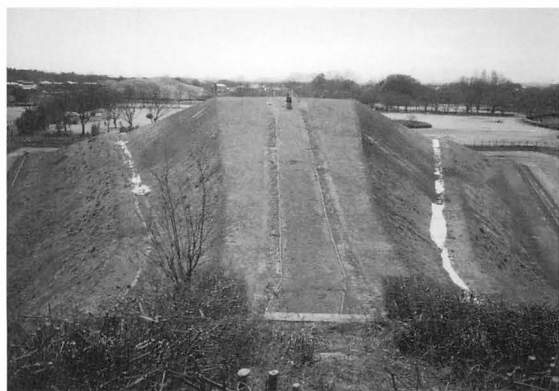
15年度 前方部園路工事
