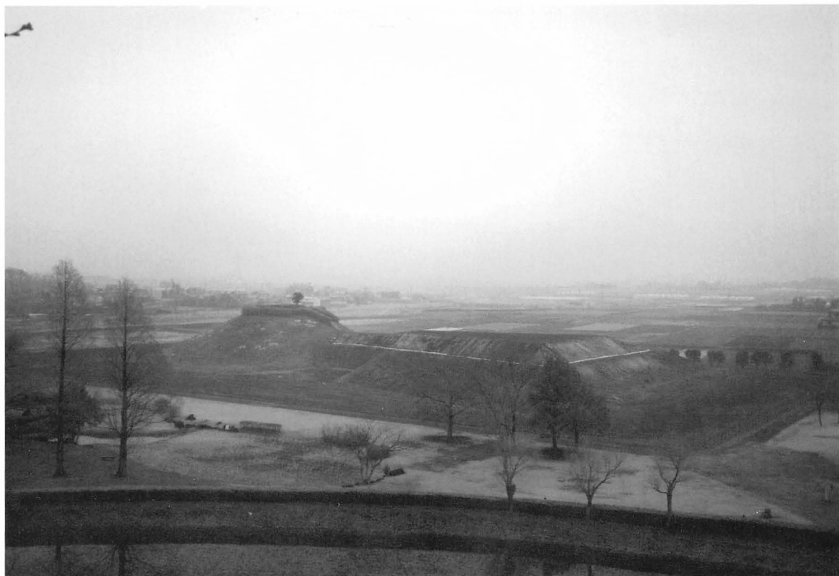
14年度工事完了状況遠景
