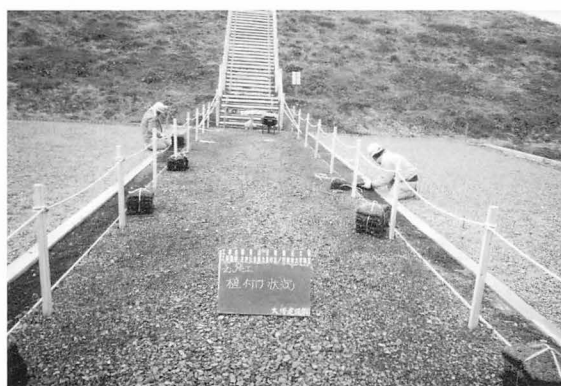
16年度 前方部園路設置工事
