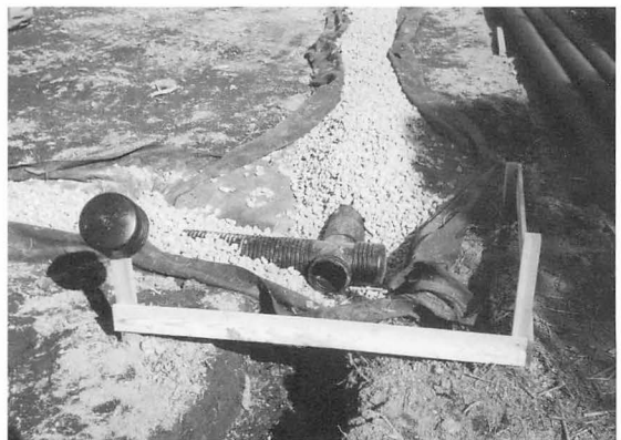
17年度 周堀排水路有孔管設置工事
