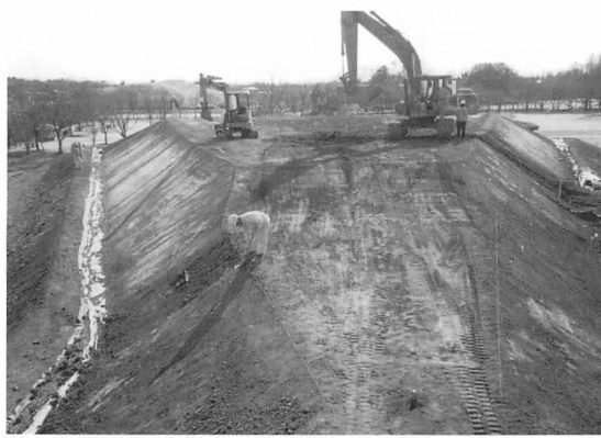
14年度 法面整形工事
