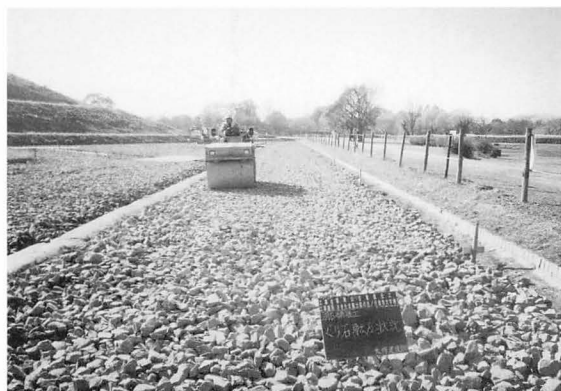
16年度 周堀修景碎石舗装工事
