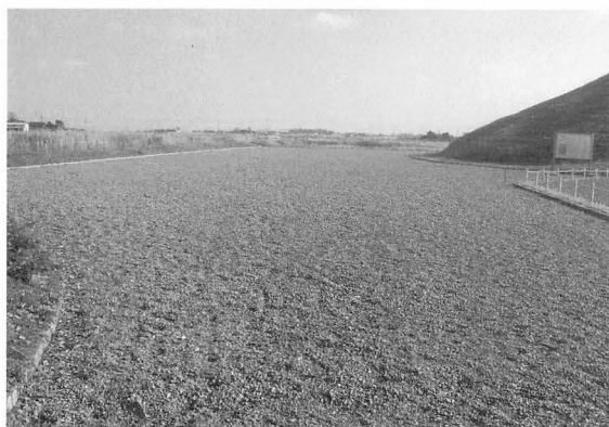
18年度 周堀敷砂利工事完了状況
