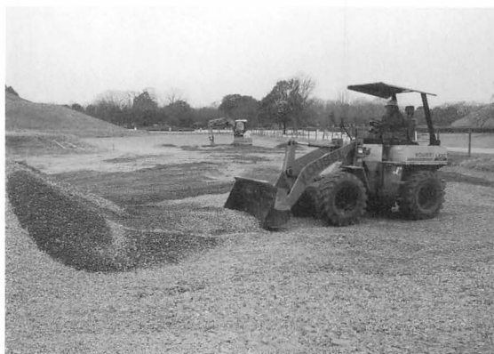
17年度 周堀修景敷砂利工事（西側）
