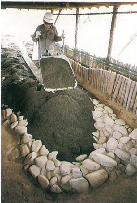
写真105 礫層の埋め戻し
