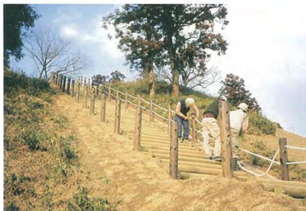
写真132 階段手すりの設置
