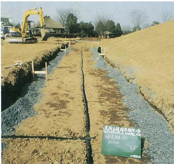
写真155 前方部正面部分の暗渠排水溝
