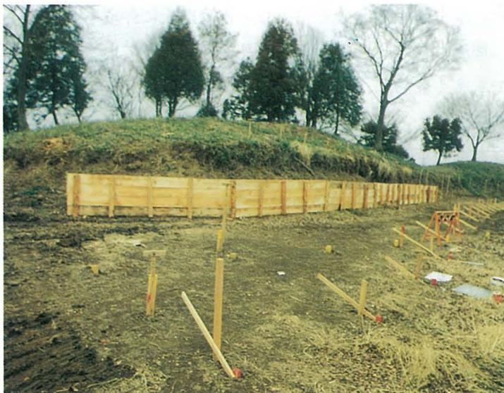
写真141 杉丸太と松板による土留工
