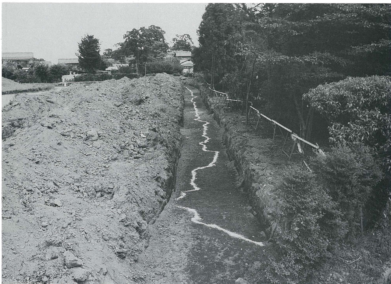
平成2年度 2T完掘状況（外堀と外堤の境界ライン）
