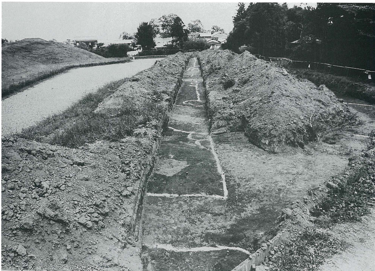
平成2年度 1T完掘状況（中堤と外堀の境界ライン）
