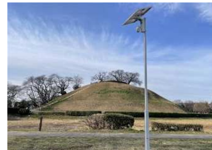
史跡監視用防犯カメラ設置工事
